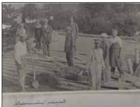
Betonování stropů, historické fotografie ze stavby školy, zdroj: Kronika školy
