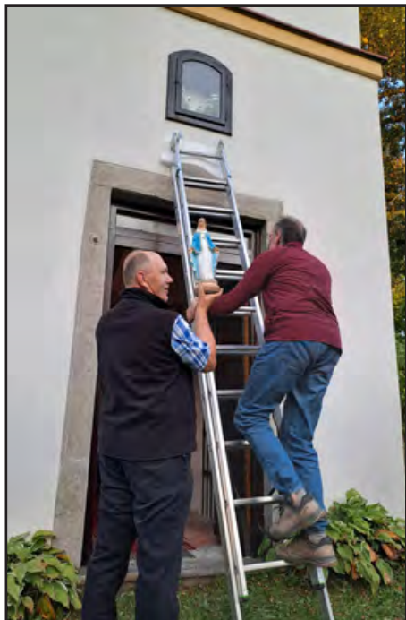
Instalace sošky P. Marie do naddveřního výklenku se ujali pánové Matyáš a Flekr
