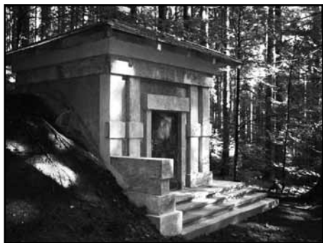
Vodojem Hladová Voda
